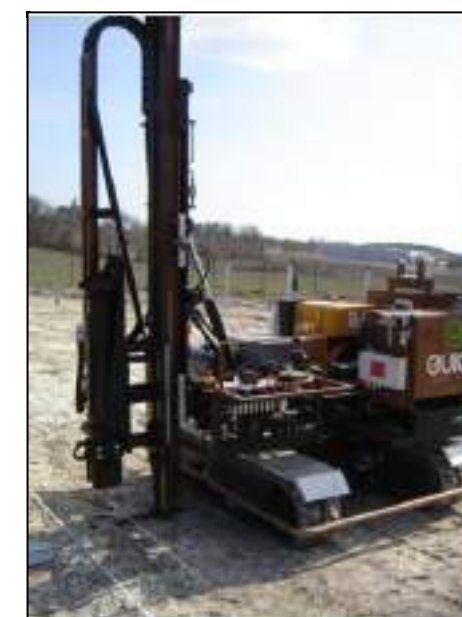
Engin de battage de pieux
