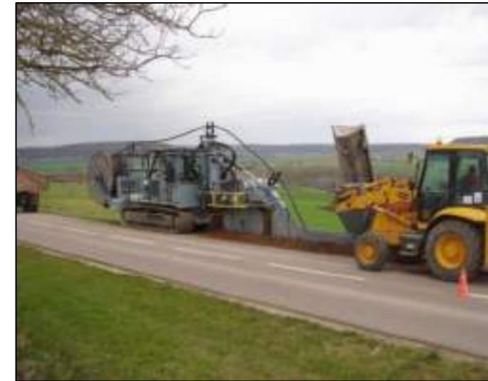
Réalisation d'une tranchée
